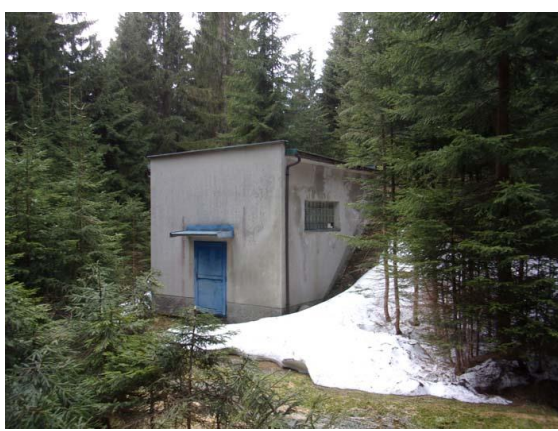
Pohled na vodárnu
