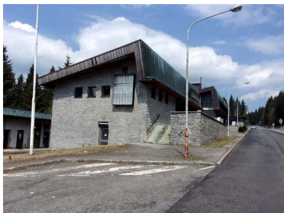
Objekt č. p. 444 (původně restaurace)
